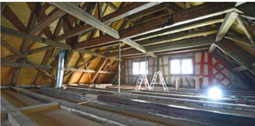
Die originale Dachkonstruktion war noch weitgehend vorhanden und konnte mit den alten Balken beibehalten werden. Oben links: Architekt Ruedi Egli im alten Dachgeschoss.
